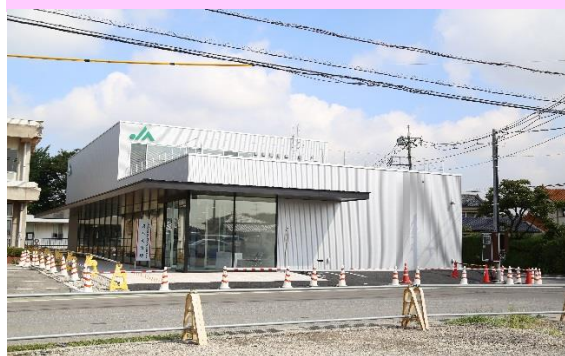
大谷支店 外観
