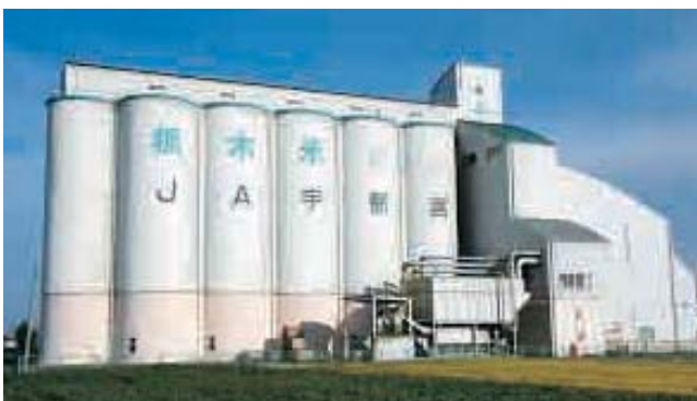
⑦カントリーエレベータでは農家の人が稲刈りした「もみ」を乾燥し、サイロに保管します。「お米」が必要な時に、もみ摺りをして「お米」を出荷します。
